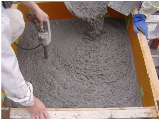
コンクリート打設
