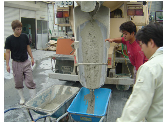
生コン車による打設
