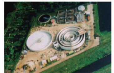
現在の下水処理プロセス(バイオリアクター)
