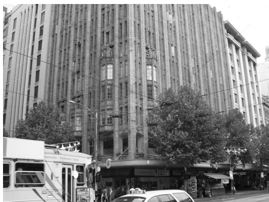
市役所前に立地する 既設のビルを活用したインキュベータ
