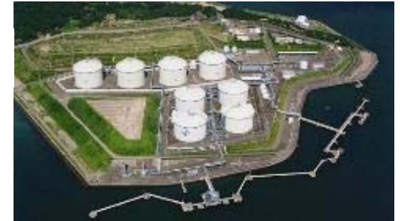
福島国家備蓄基地及び民間隣接基地
